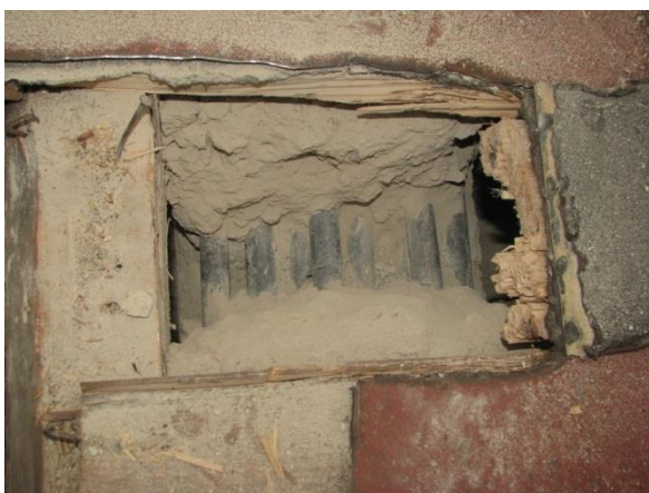
Foto 6.3.12.1 Detail vyztužení v místě sondy S11
