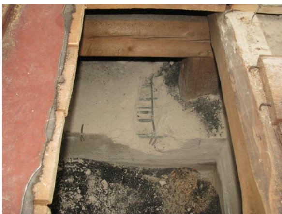
Foto 6.3.13.1 Detail vyztužení v místě provedené sondy S12
