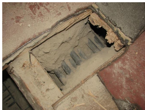
Foto 6.3.12.2 Detail vyztužení v místě sondy S11
