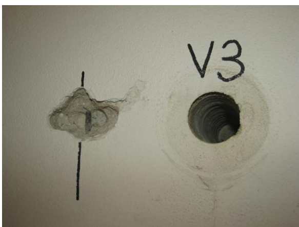
Foto 6.1.5 Pohled na odběrové místo jádrového vývrtu V3 provedeného ze stropního průvlaku
