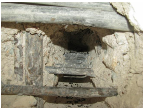
Foto 6.3.4.1 Detailní pohled na vyztužení u horního líce průvlaku nad podporou
